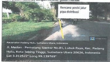
15 Rencana JDU \phi 250 mm mulai dari simp. AMD jalan Gatot Subroto sampai Simpang Brimob jalan Ahmad Yani (Jalan Nasional) dengan metode galian manual
